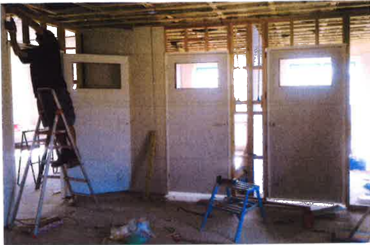
Plaatsen van de binnenwanden
