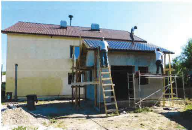
Het ketelhuis in aanbouw...
